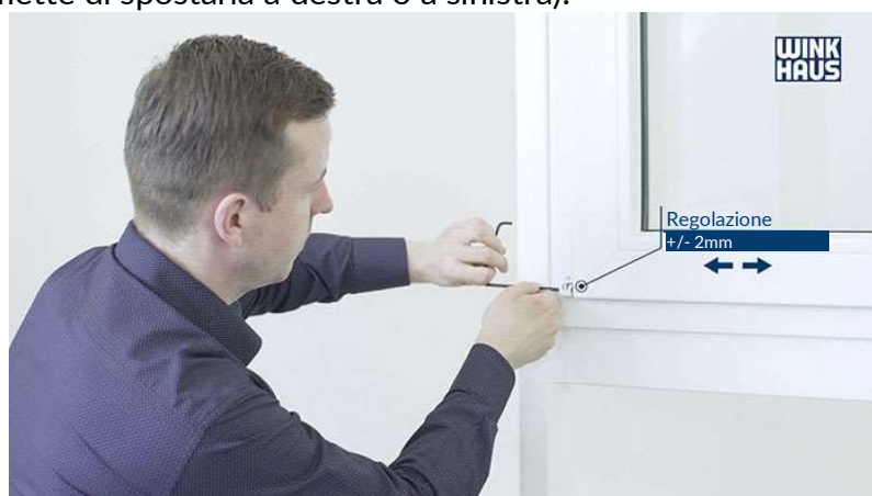
Regolazione orizzontale della cerniera del telaio
