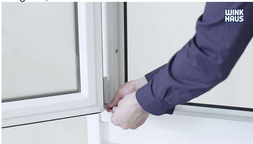
Regolazione del serraggio dell'anta al controtelaio nella finestra sinistra
