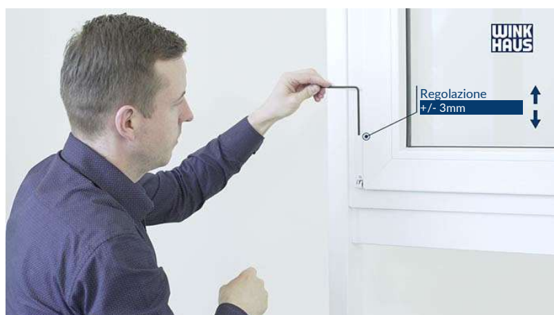
Regolazione dell'altezza sulla cerniera dell'anta
