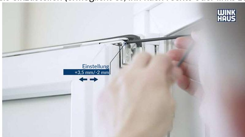
*Seitenverstellung am Scherenlager*
