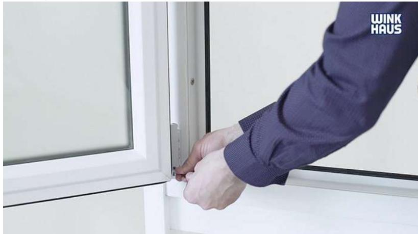
*Einstellung des Anpressdrucks des Flügels an der Zarge am linken Fenster*
